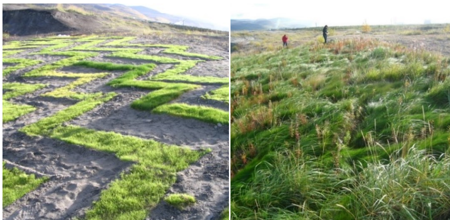
Рис. 12. Биорекультивация пологого склона хвостоотвалов АНОФ-2 с помощью инновационного экспресс-способа — шевронного настила ковровой травяной дернины:
