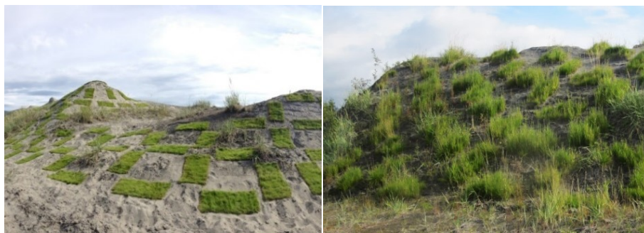
Рис. 13. Биорекультивация склонов на хвостоотвалах АНОФ-2 с помощью инновационного экспресс-способа — шахматного настила ковровой травяной дернины:
