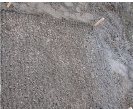
Рис. 21. Прямой посев травосмеси непосредственно на поверхность грунта. Фото Л. А. Ивановой
