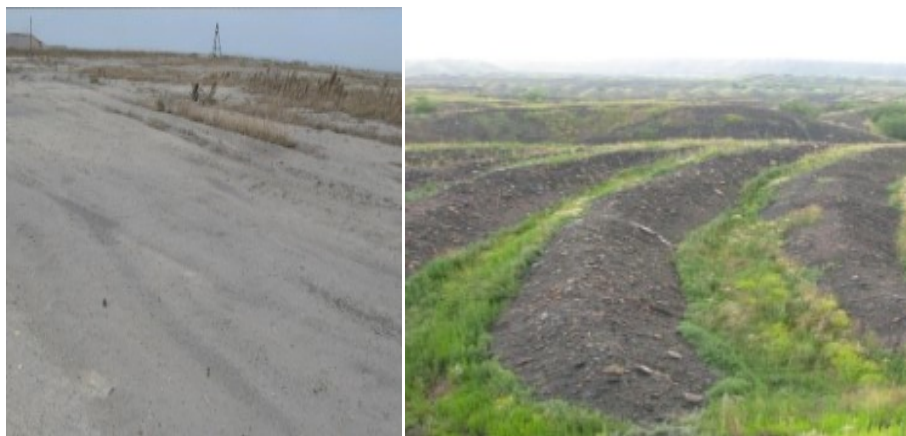
а б Рис. 9. Пример биологической рекультивации хвостовых отвалов традиционным посевным способом с проведением выполаживания и нанесения на поверхность техногенного грунта слоя почвосмеси: а — до начала проведения работ; б — результат после завершения. Фото Л. А. Ивановой
