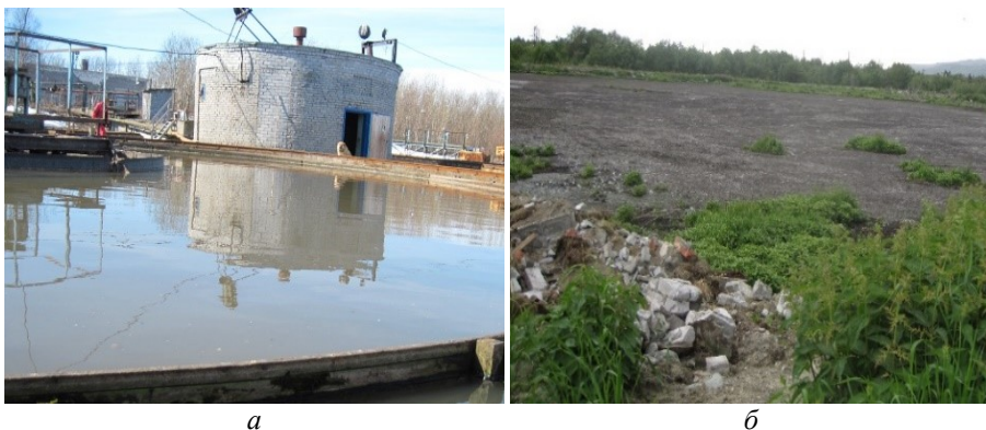
Рис. 15. Водопроводно-канализационное хозяйство АО «Апатитыводоканал»: а — осветление сточных вод на КОС-3 г. Апатиты; б — один из иловых накопителей ОСВ. Фото Л. А. Ивановой
